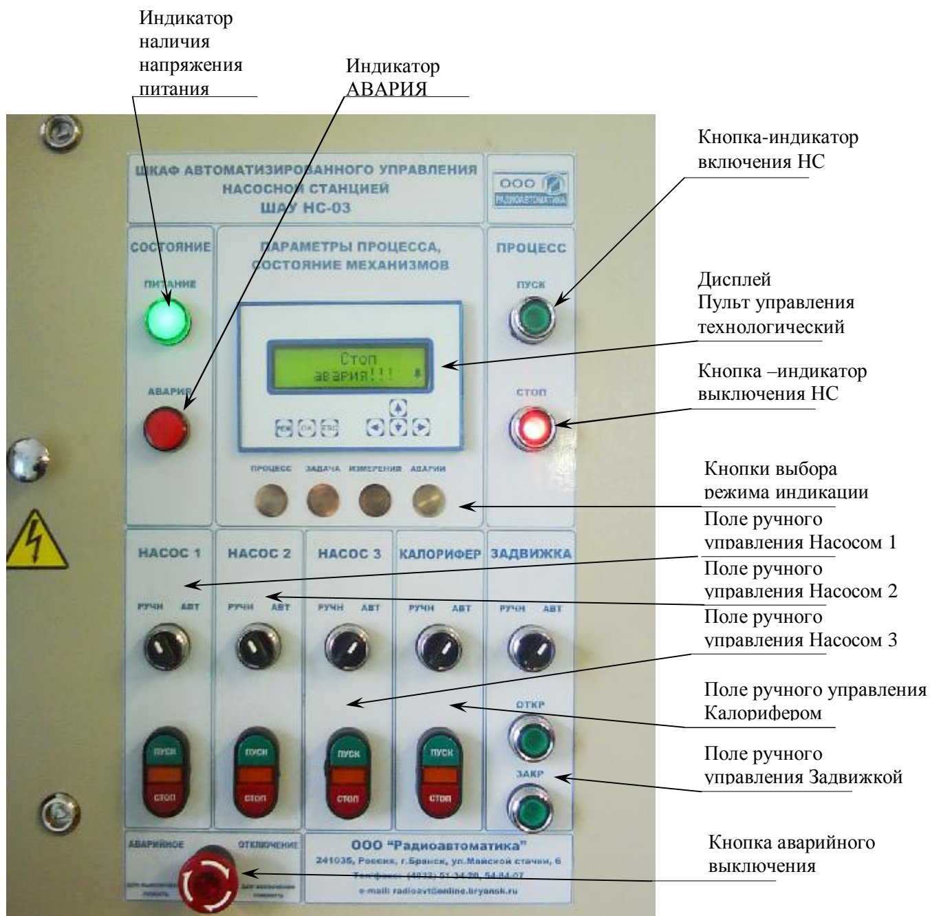
Рисунок 3. Внешний вид пульта управления ШАУ НС
